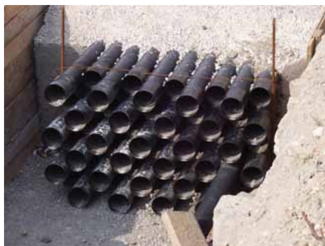
Privaděč na most Apolo Bratislava Privádzač na most Apolo Bratislava
