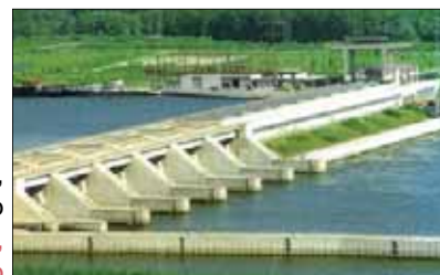
elektrárna, Rakousko elektrárna, Rakúsko
