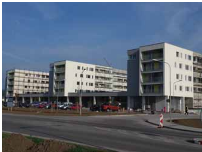
Residence Hron, Zvolen - materiál HFT, krabice Residencia Hron, Zvolen - material HFT, krabice
